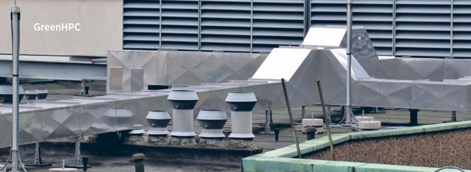
Abb.4: Wärmeleitung über das Dach des DKRZ-Gebäudes zu den Laboren im Nachbargebäude.
