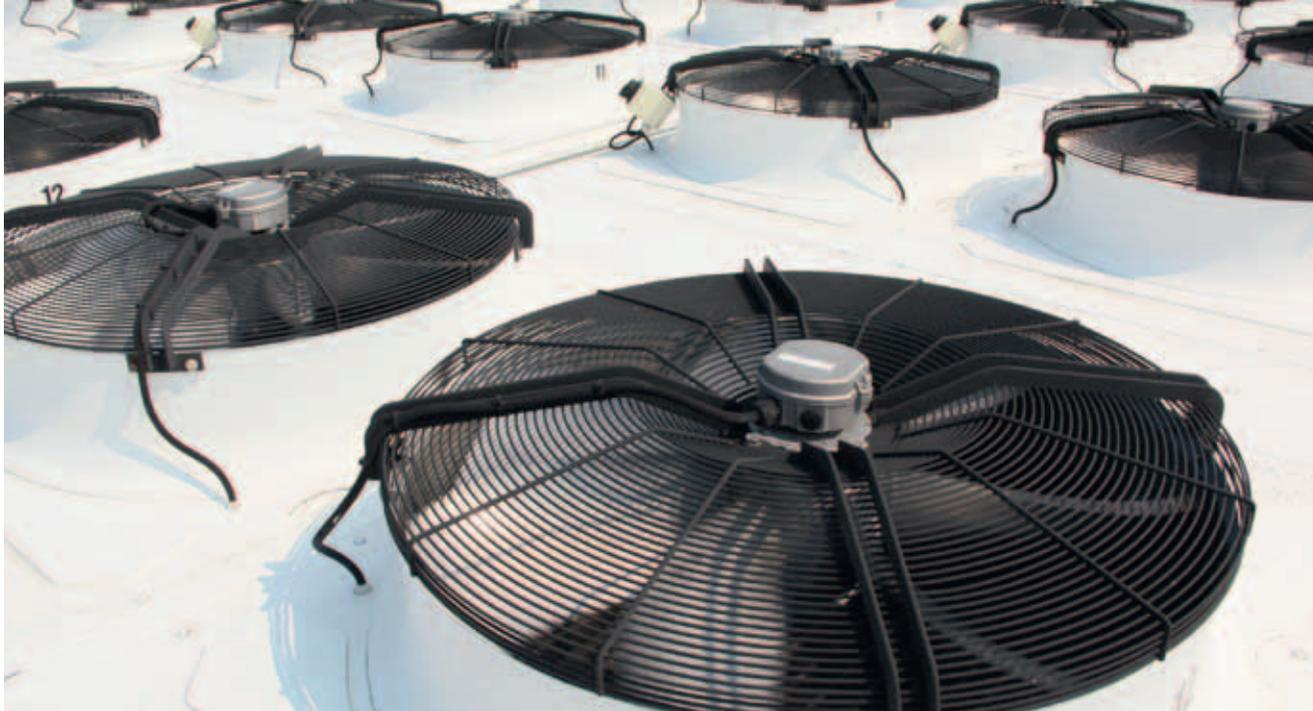
Auf dem Dach des DKRZ sind Ventilatoren installiert. Sie geben die vom Rechner produzierte Wärme ins Freie ab.
