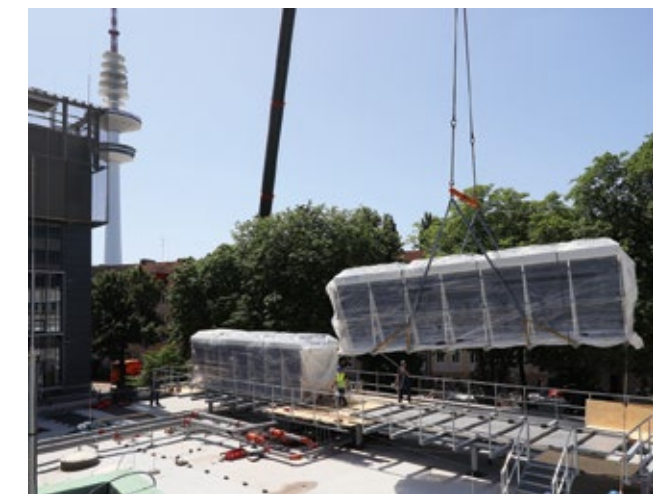
Abb. 6: Installation der Rückkühlwerke für Levante auf dem Dach des Nachbargebäudes.
