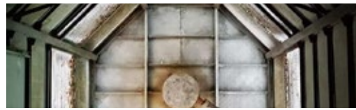
Januar 2021 Energieeffizienz: 3.500 Megawattstunden Abwärme von Supercomputer Mistral in Chemielaboren nebenan genutzt
