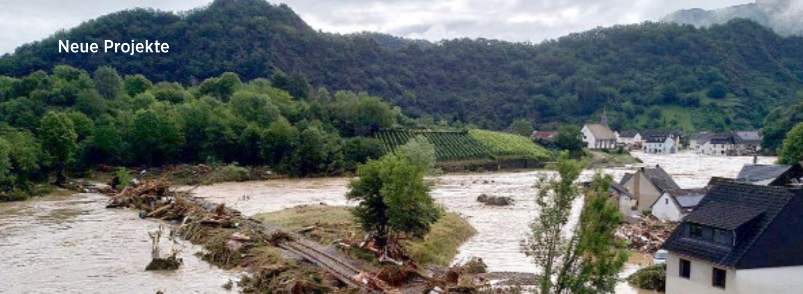
Abb. 25: Hochwasser in Altenahr-Altenburg am 15. Juli 2021.
