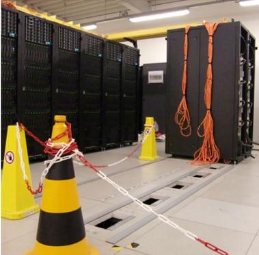
Mit der Anlieferung der ersten zehn Rechnerschränke wurde die Installation der zweiten Ausbaustufe des Hochleistungsrechnersystems für die Erdsystemforschung 3 (HLRE-3) "Mistral" sichtbar eingeläutet. Mit der zweiten Ausbauphase, die in diesen Tagen installiert wird, steigen Rechenleistung und Festplattenkapazität des HLRE-3 auf mehr als das Doppelte.
