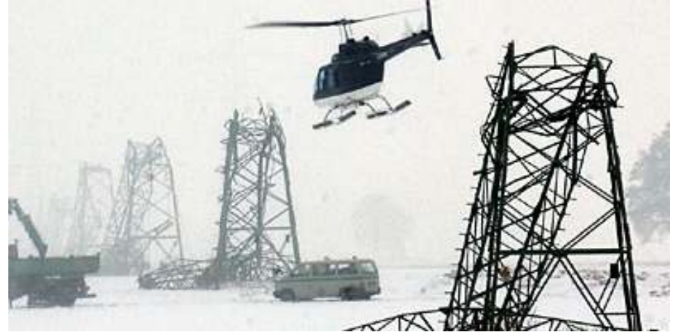
Electrical tower close to Münster Sueddeutsche.de 04.12.2005
